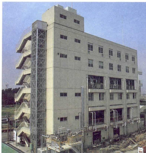
パイロットプラント棟
