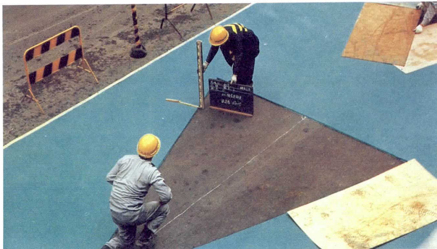
道路のカラー舗装
