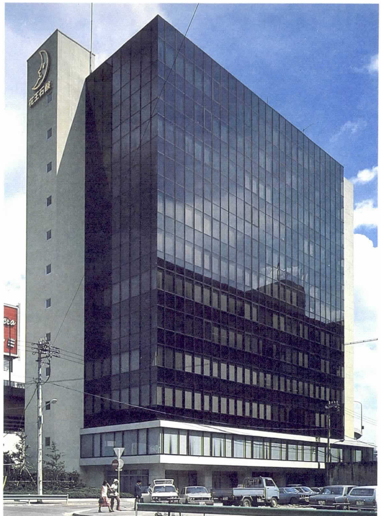
本社ビル(東京 茅場町)
