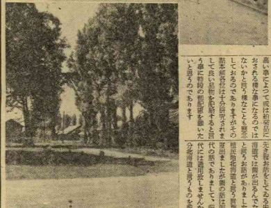
寫眞説明 上は市街の風景、下はウヰヤ木製船の修繕
