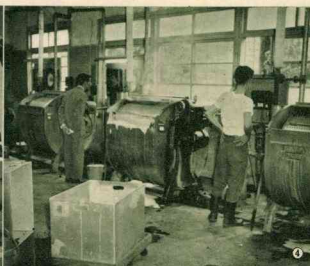
染色用のスミス・ドラム。縫合わされた靴下は袋に入れられこの染色機に投入される。回転式にムラなく染色され、脚線美に光彩を添えるわけである。
